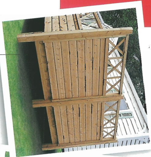
Claustra parevue/paravent. Hauteur de rambarde 1m40.
